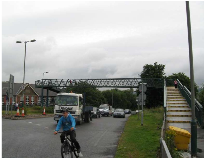
Trecenydd Footbridge from Trecenydd Roundabout
